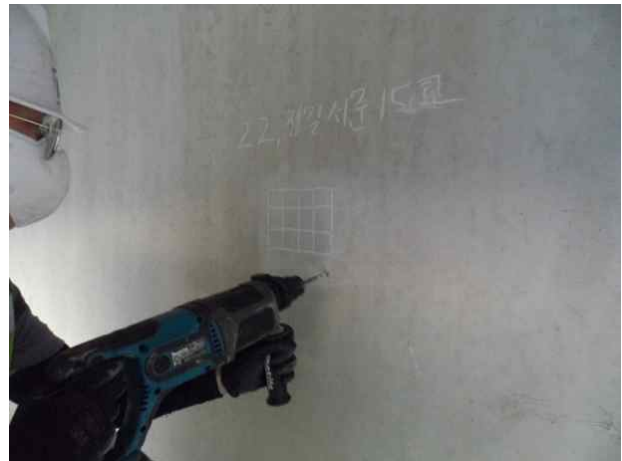
탄산화깊이 측정 현황
