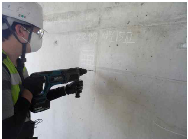
탄산화깊이 측정 현황
